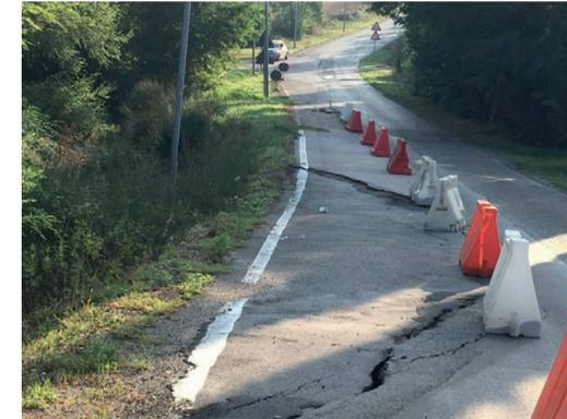
Nel tratto di strada (circa 200 metri) più danneggiato, l'intervento vedrà la realizzazione, in entrambi i lati della carreggiata, di una palificata verticale costituita da piloni di cemento armato uniti tra loro da travi orizzontali semipre in cemento armato. Una sorta di viadotto interrato. Quando il cantiere entrerà nel vivo la strada resterà chiusa al traffico. I lavori, a seguito di bando di evidenza pubblica, saranno eseguiti dalla ditta Menconi Srl con sede legale a Montepulciano ■
