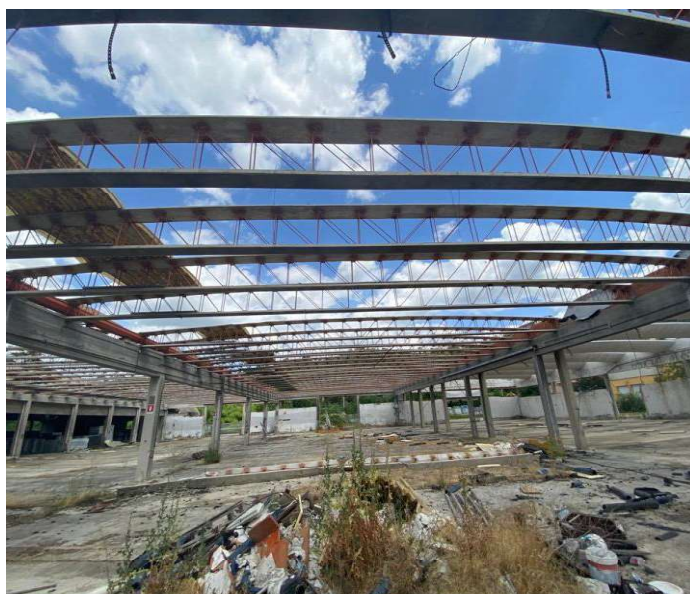
Vista interna area centrale
