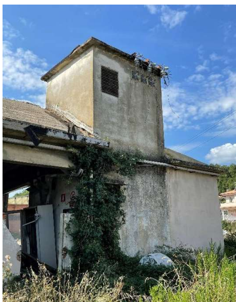
Vista del manufatto di cabina
