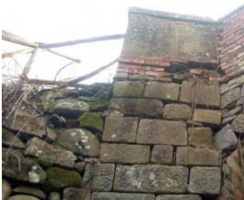
Figura 12. Esempio allentamento maglia muraria muri d'ala
