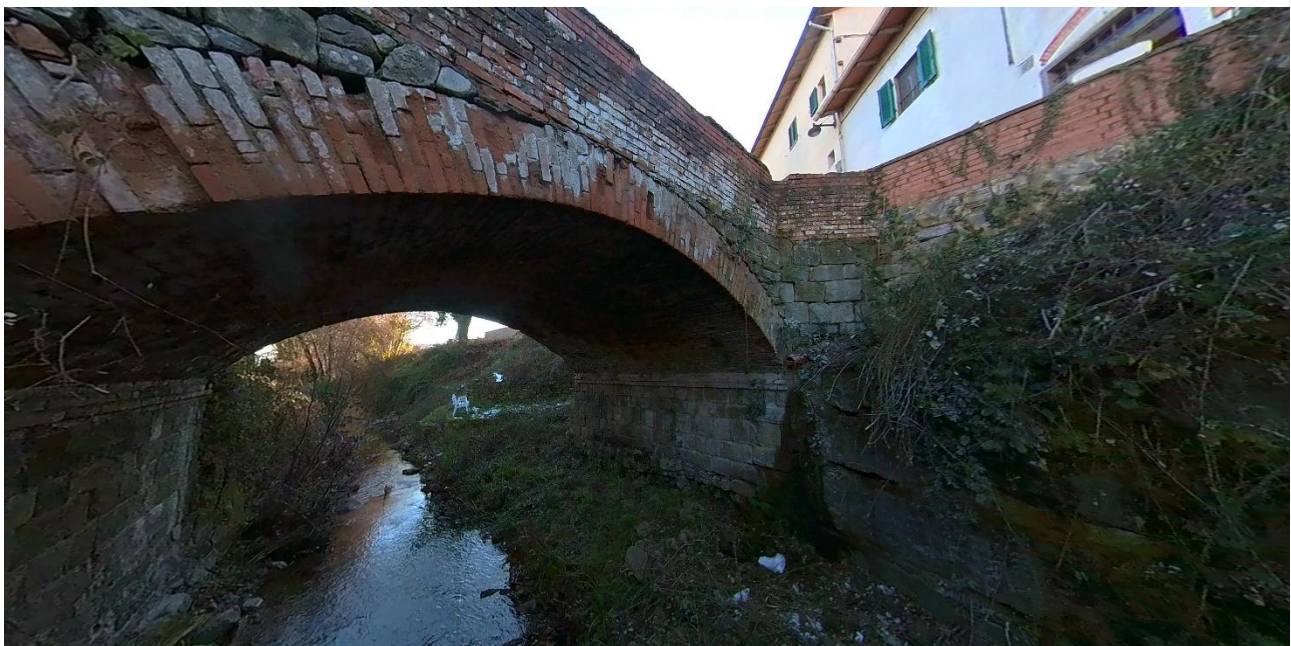
Figura 3. Vista del ponte da ovest
