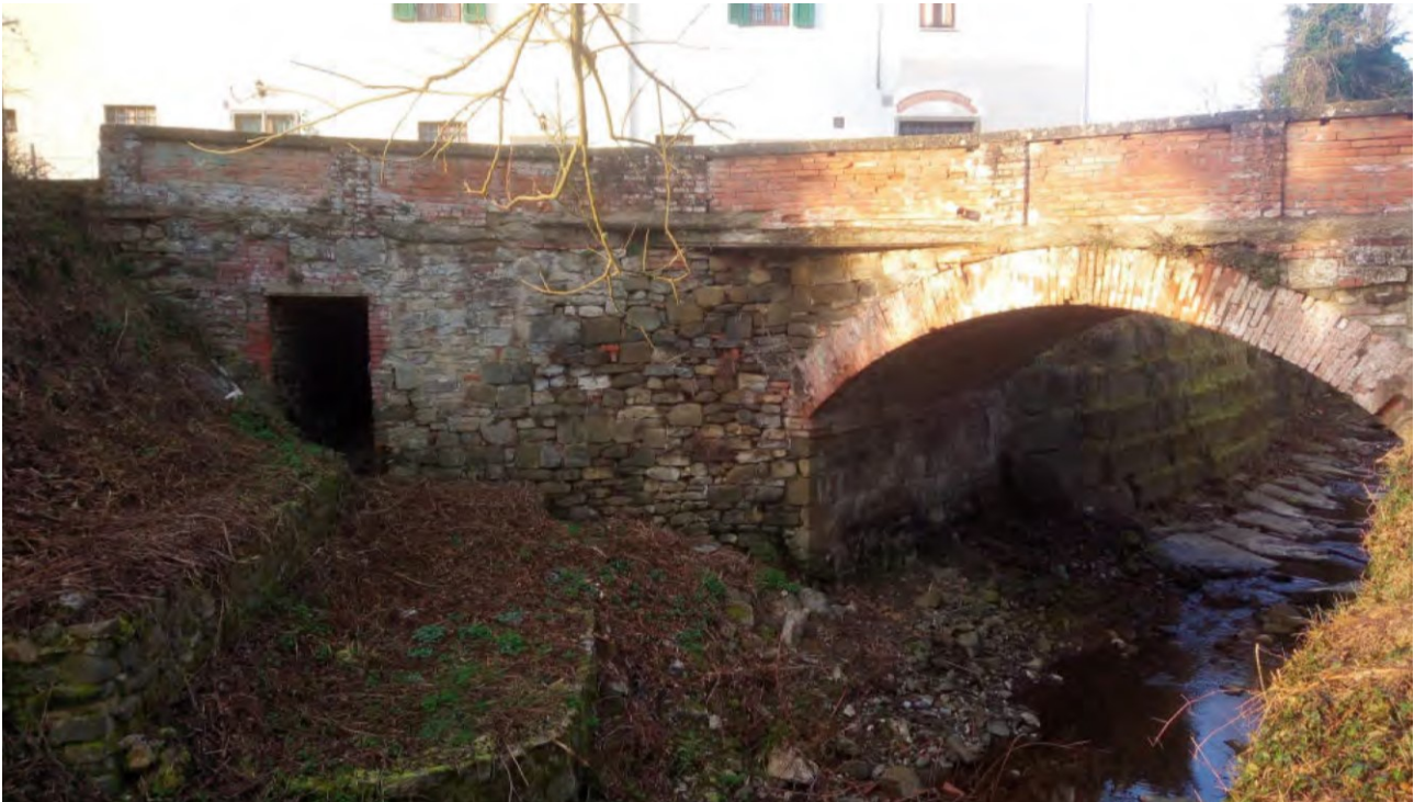
Figura 15. FOTO 1 – Vista del lato est del ponte
