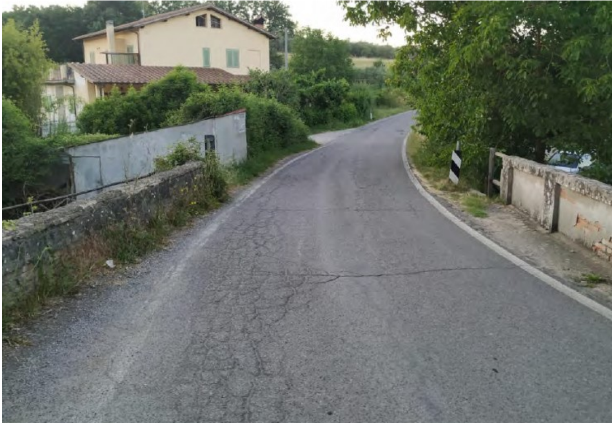
Figura 21. FOTO 7 - Vista nord della strada superiore
