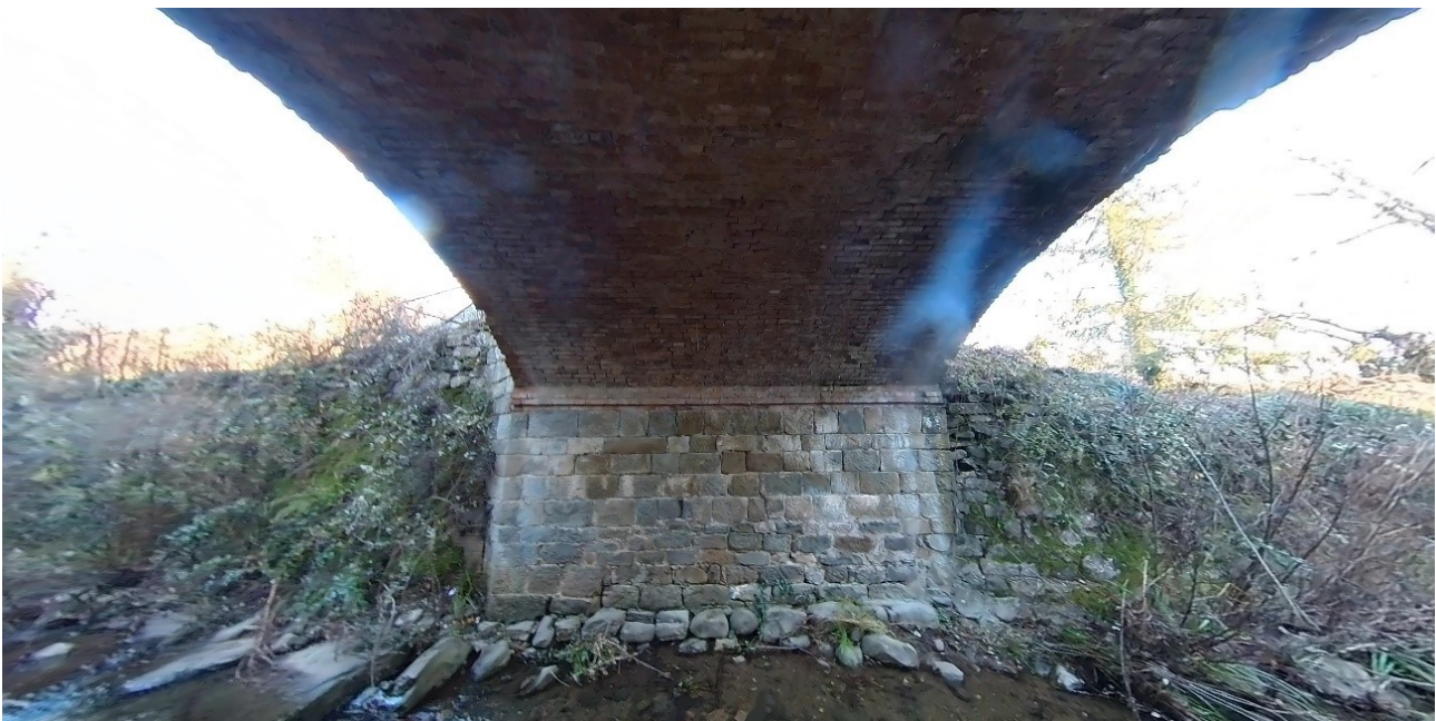
Figura 18. FOTO 4 - Vista intradosso della volta in mattoni e spalla in pietra
