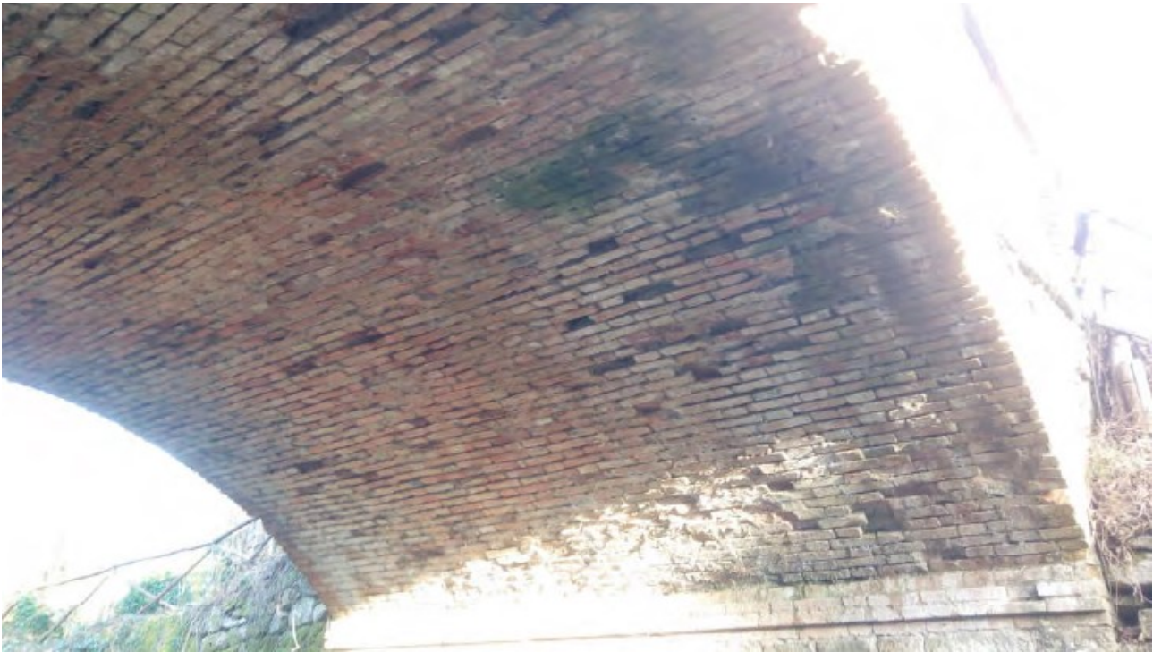
Figura 19. FOTO 5 - Vista intradosso della volta in mattoni
