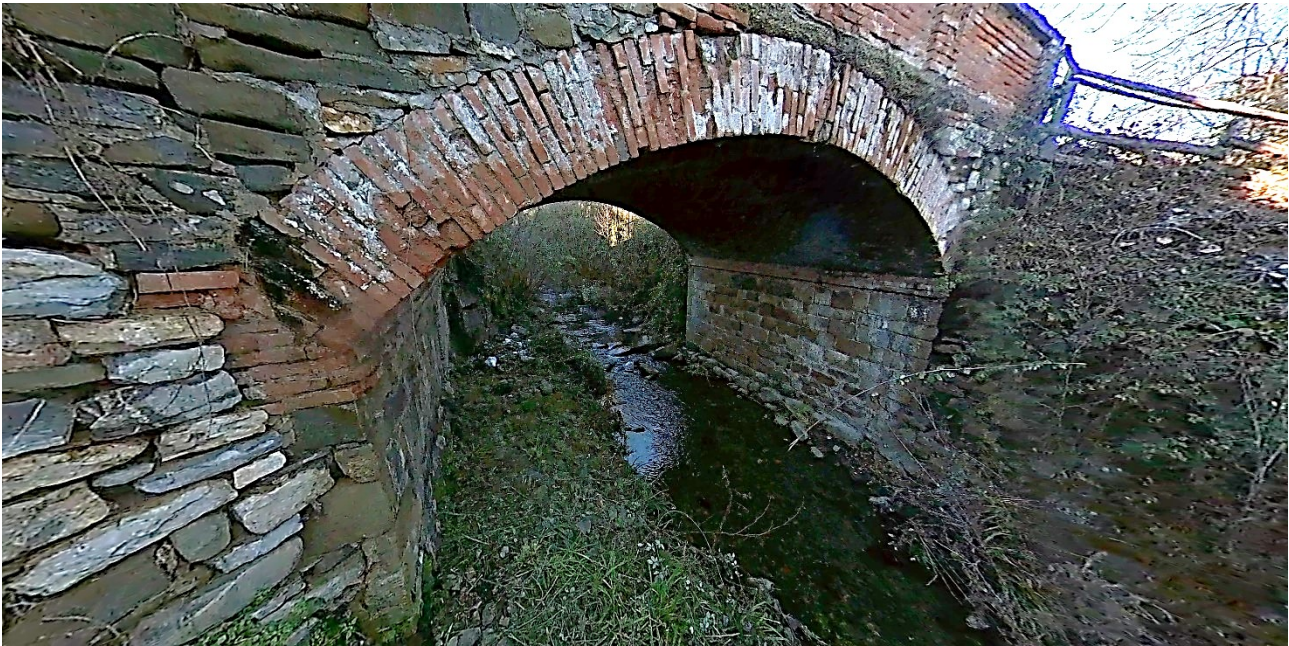
Figura 17. FOTO 3 - Vista del lato ovest del ponte
