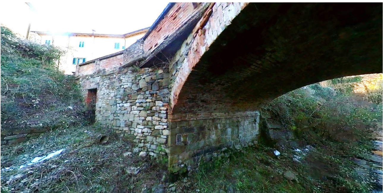
Figura 16. FOTO 2 – Vista del lato est del ponte
