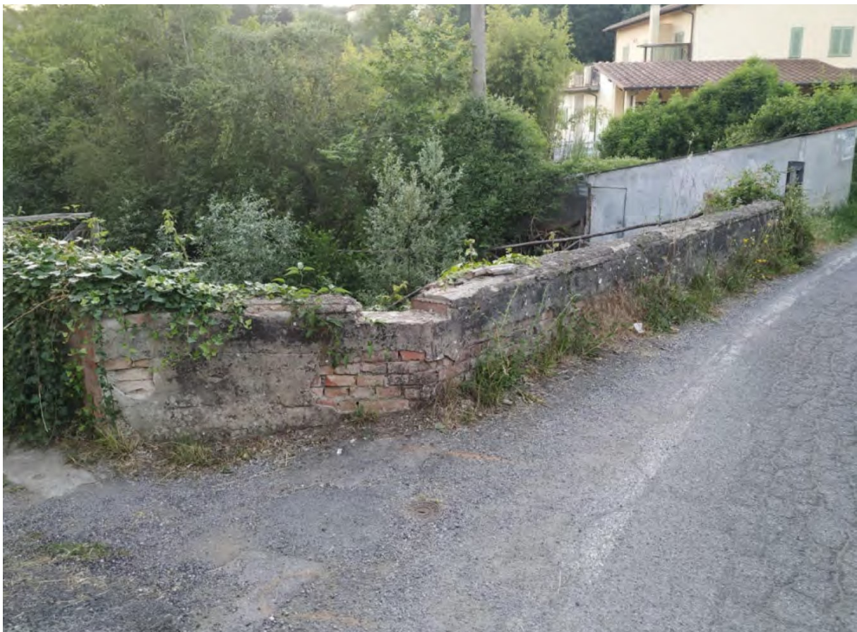
Figura 22. FOTO 8 - Parapetto in mattoni pieni
