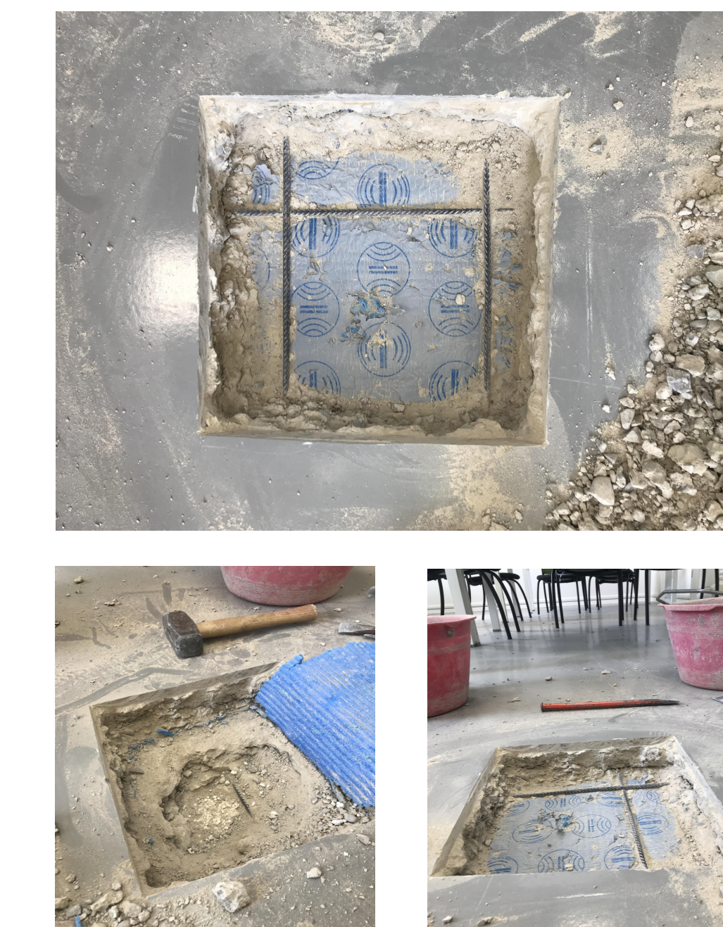
Rilievo fotografico del saggio eseguito in loco per verificare la stratigrafia presente nel solaio. Vedi riferimento posizione nelle piante dello Stato di fatto.
