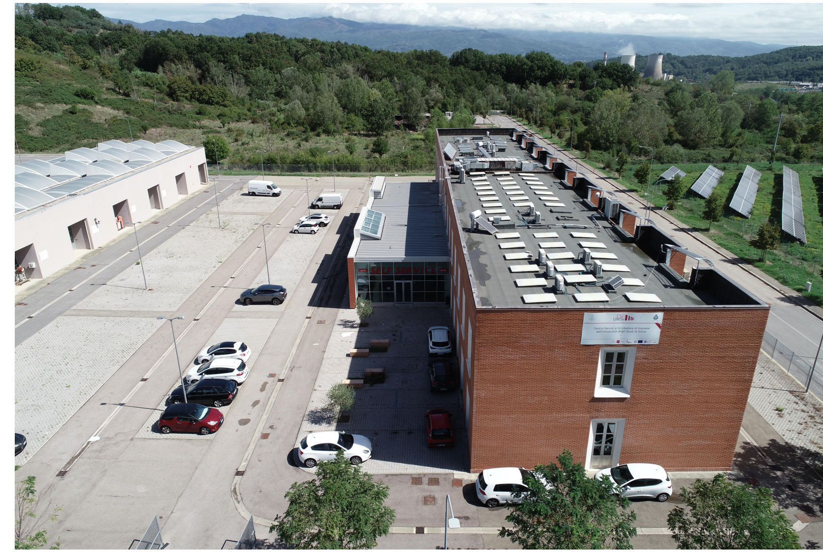
Rilievo fotografico dell'edificio esistente realizzato con il drone.
