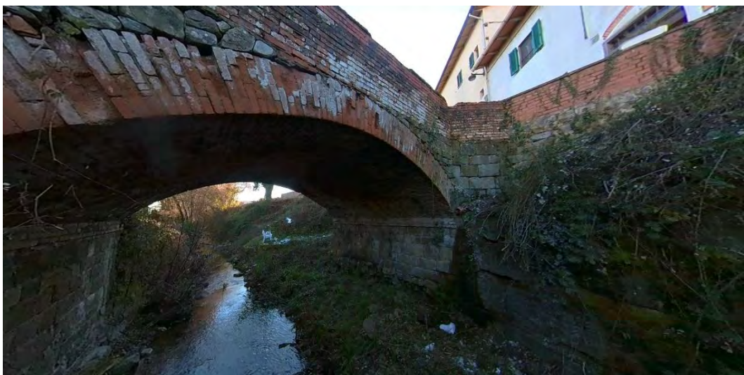
Figura 3. Vista del ponte da ovest
