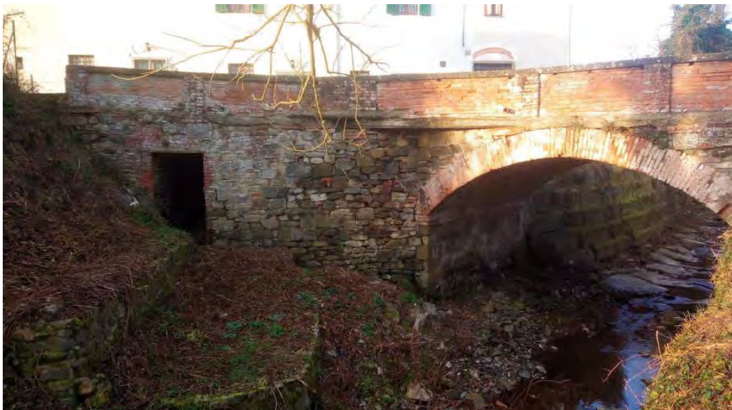
Figura 2. Vista del ponte da est
