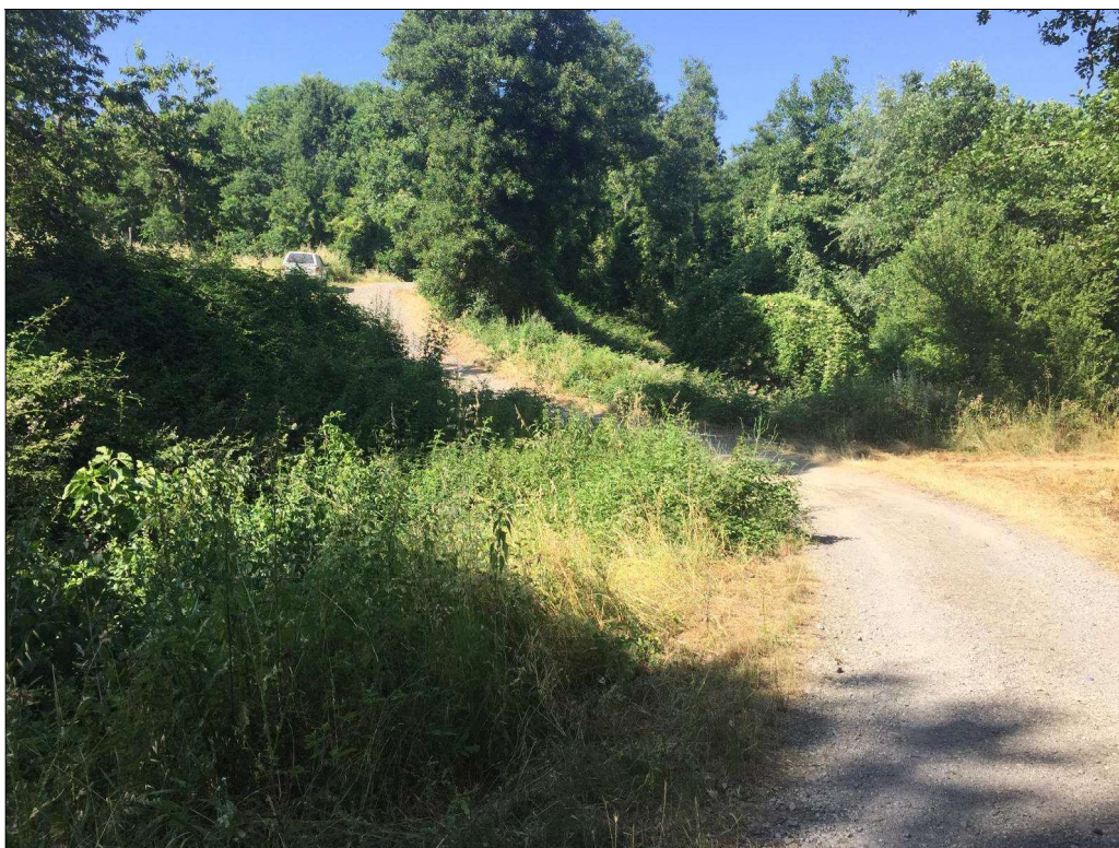
Fig. 8 – vista del ponte verso valle, provenendo dalla S.P. n.14
