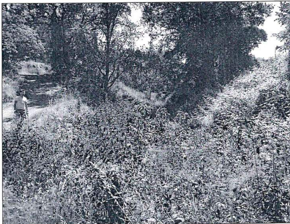
Fig. 5 – vista dal ponticello verso monte (in lato sulla sinistra il raccordo della stradella con la S.P. n. 14)
