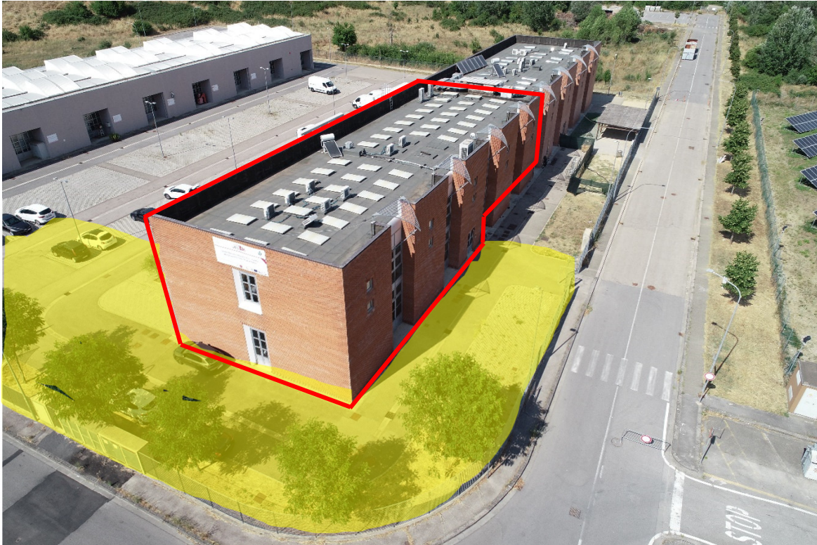
Figure 1 – Individuazione dell'area di cantiere e della porzione di edificio interessata.
