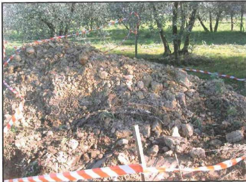
Fot n° 2 – materiale prelevato dallo scavo: limi sabbioso-argillosi con discreta consistenza e compattezza.
