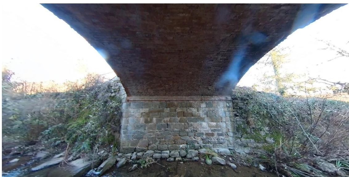
Figura 11 FOTO 4 - Vista intradosso della volta in mattoni e spalla in pietra
