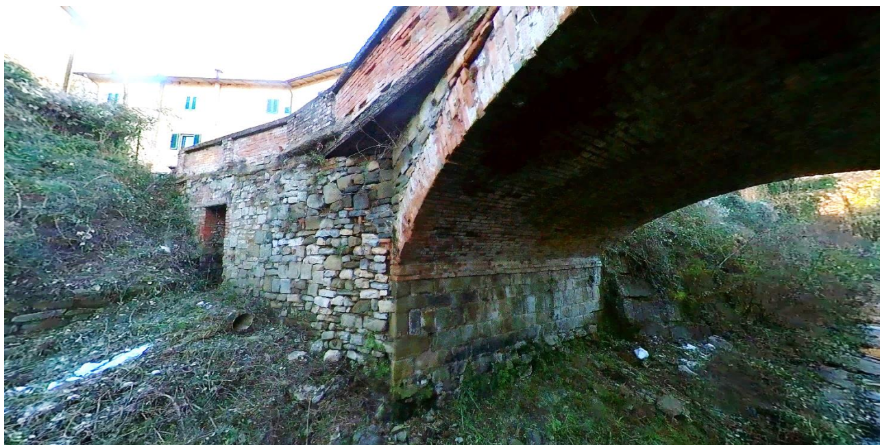
Figura 9 FOTO 2 – Vista del lato est del ponte
