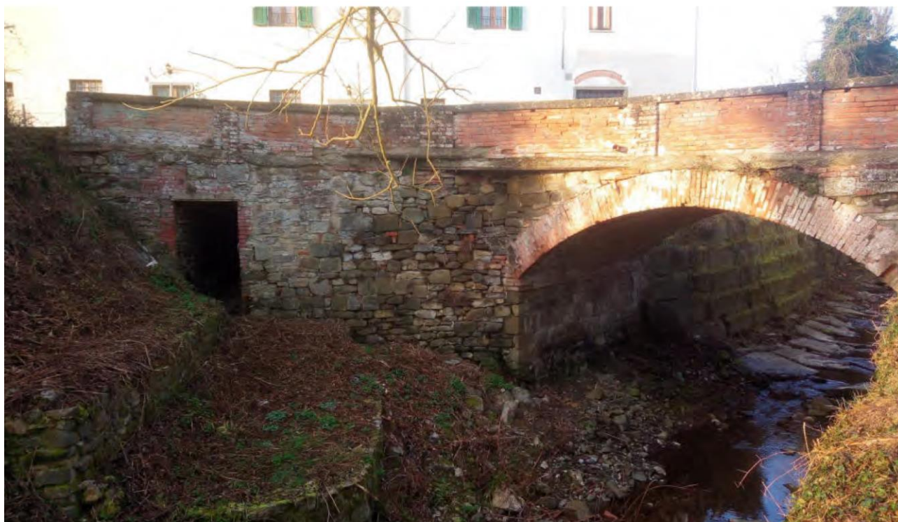
Figura 8 FOTO 1 – Vista del lato est del ponte
