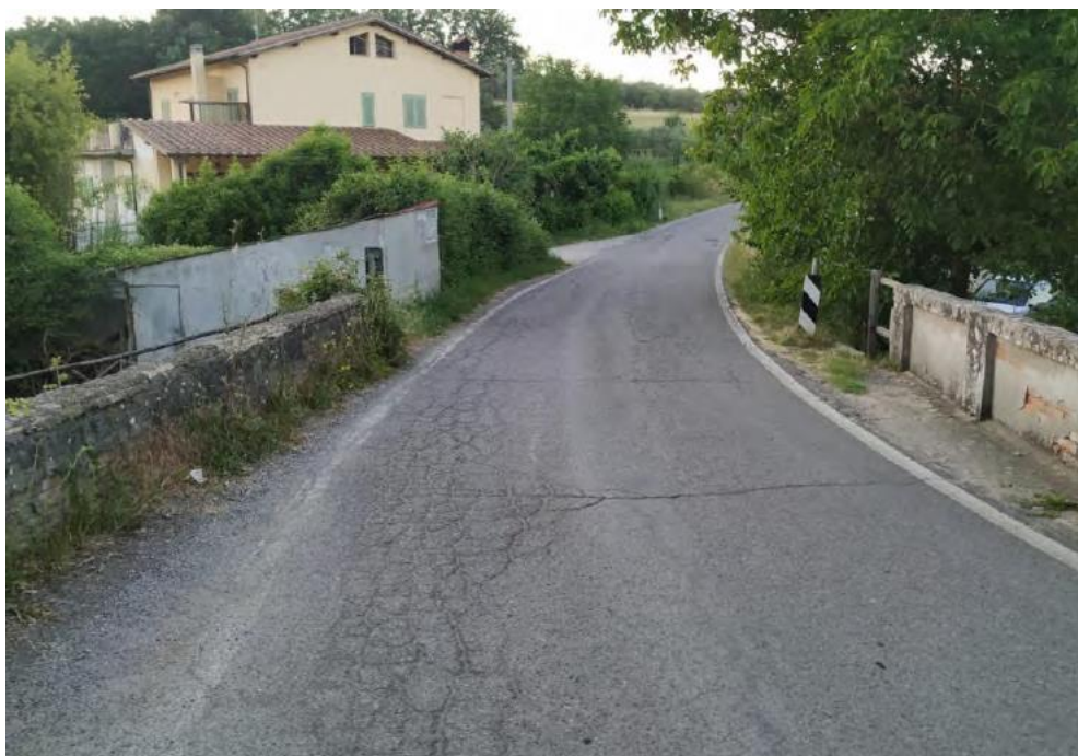
Figura 14 – FOTO 7 - Vista nord della strada superiore
