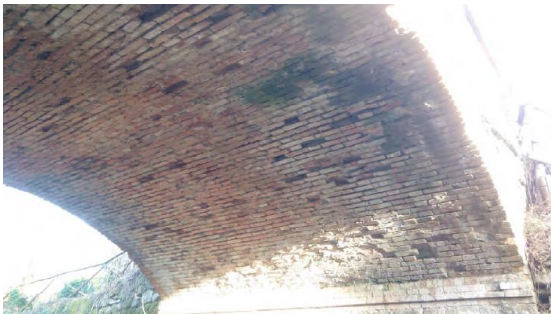
Figura 12 FOTO 5 - Vista intradosso della volta in mattoni
