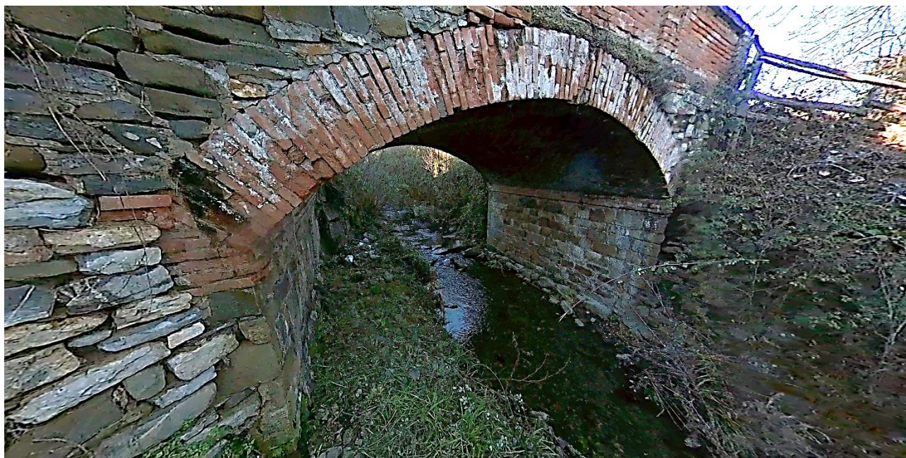
Figura 10 FOTO 3 - Vista del lato ovest del ponte
