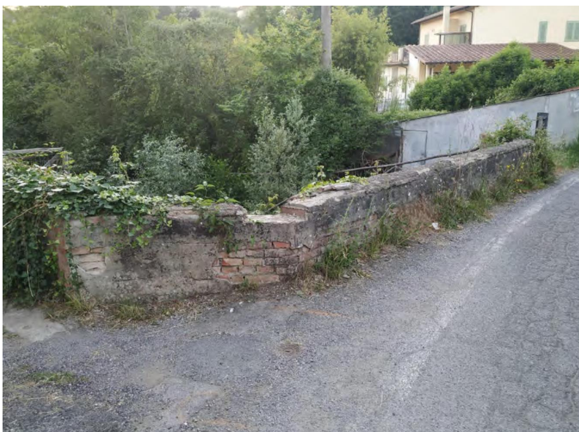
Figura 15 FOTO 8 - Parapetto in mattoni pieni
