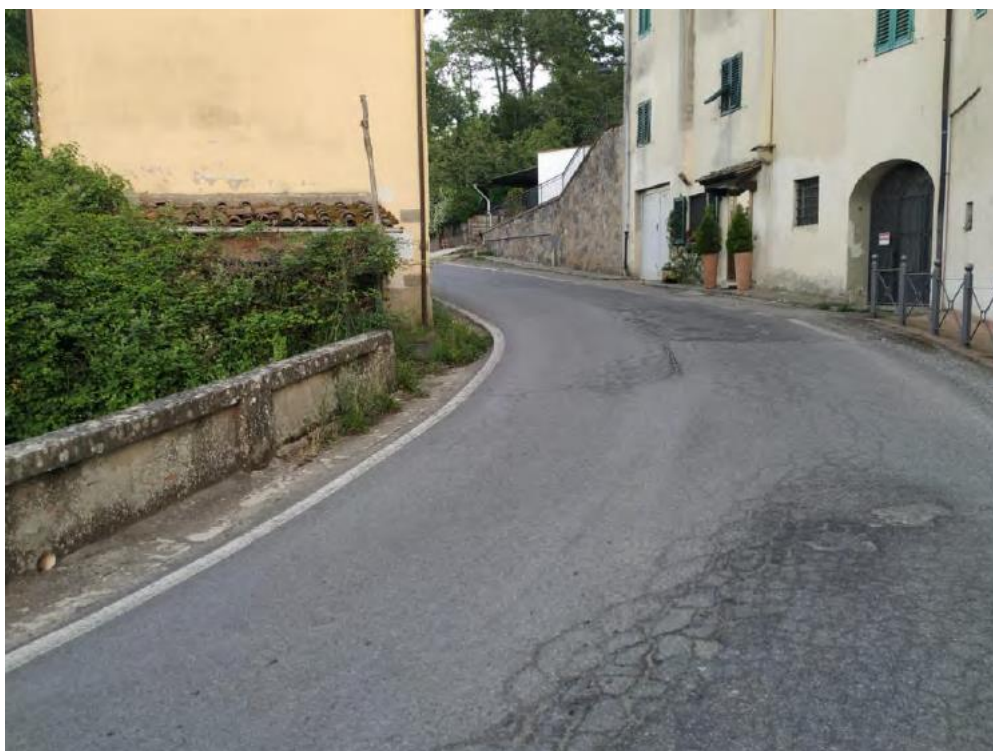
Figura 13 FOTO 6 - Vista sud della strada superiore
