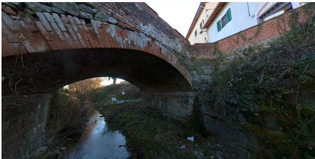
Figura 3 - Vista del ponte da ovest
