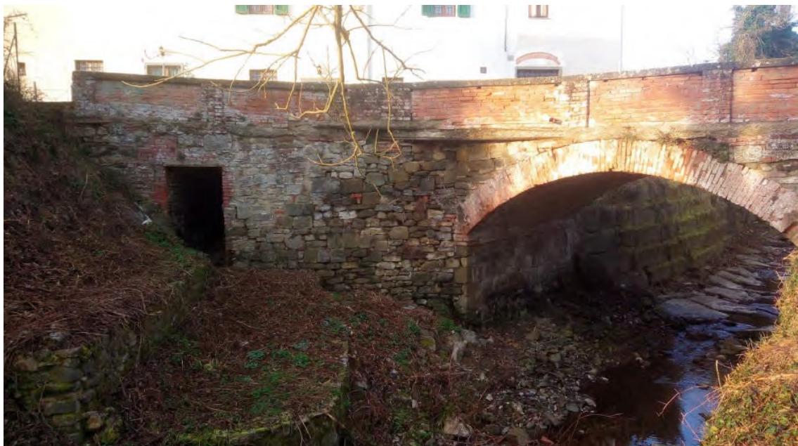
Figura 2 - Vista del ponte da est
