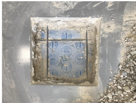
Figura 5 – Estratto immagini dei saggi eseguiti per la verifica della presenza del tappetino nel corpo esistente
