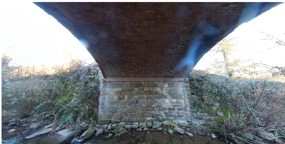
Figura 5 Vista intradosso della volta in mattoni e spalla in pietra
