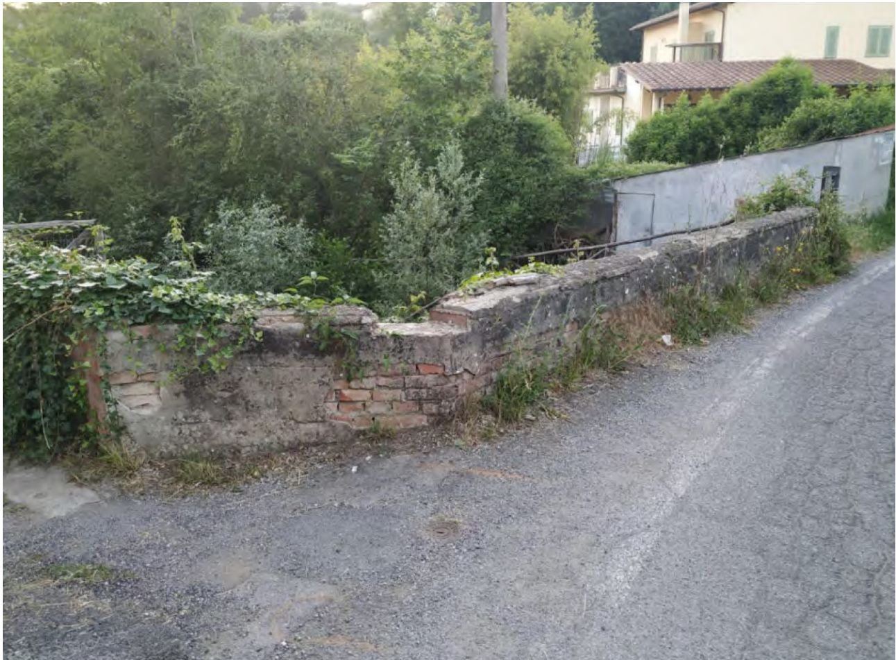
Figura 9 Parapetto in mattoni pieni
