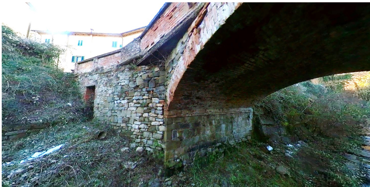
Figura 3 Vista del lato est del ponte
