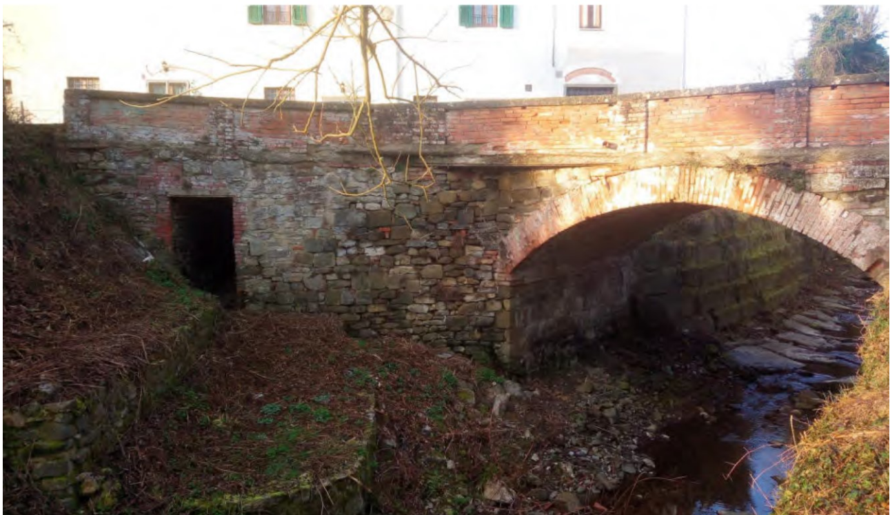
Figura 2 – Vista del lato est del ponte
