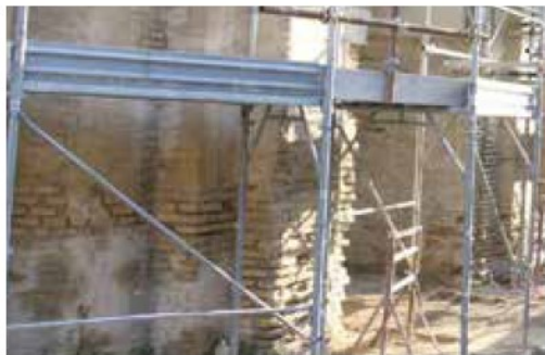
Figura 43 Muratura pre - intervento
