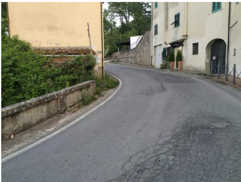
Figura 7 Vista sud della strada superiore
