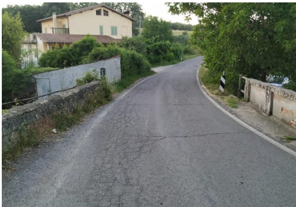
Figura 8 Vista nord della strada superiore
