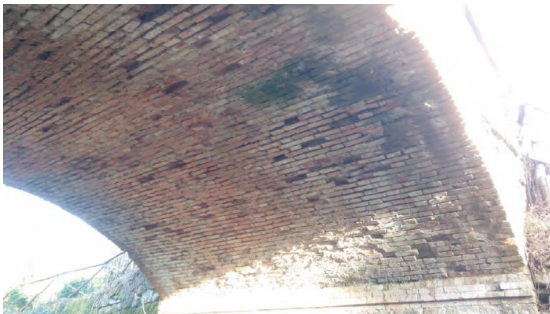
Figura 6 Vista intradosso della volta in mattoni
