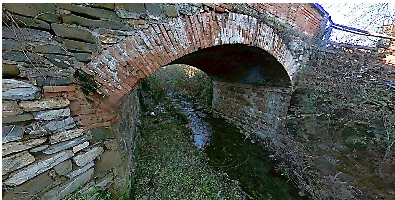
Figura 4 Vista del lato ovest del ponte
