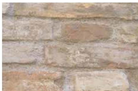
Figura 44 Muratura post - intervento
