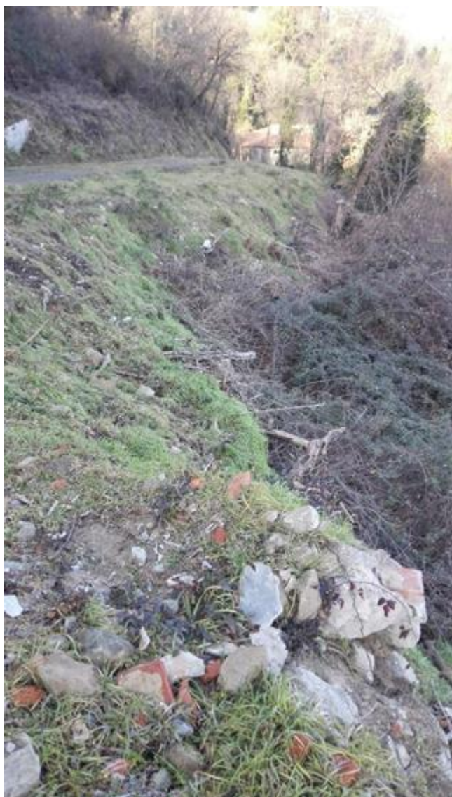
Figura 46 – Coronamento di una frana di scorrimento rotazionale a spese dei depositi di riporto per la realizzazione della strada ed in misura minoritaria della copertura alteritica delle arenarie lungo la strada tra Borgo Vecchio e l'edificio destinato ad ex distributore di carburante (sullo sfondo).
