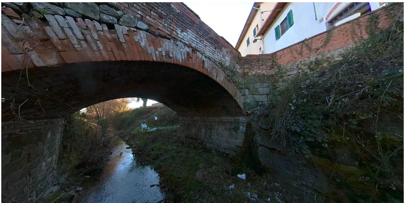
Figura 3. Vista del ponte da ovest
