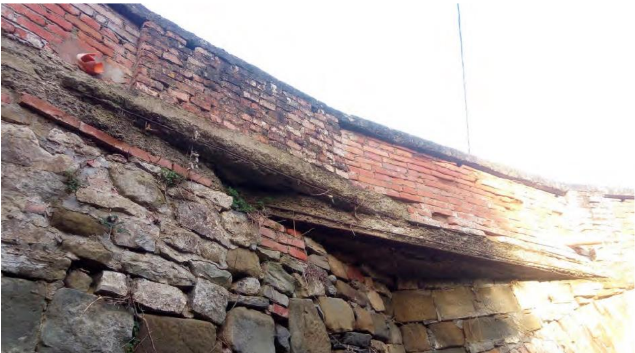
Figura 5. Vista del parapetto in muratura
