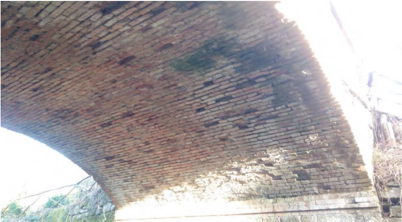
Figura 4. Vista della volta
